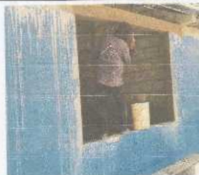
Foto 6: Tallando las bases de las ventanas para la Telesecundaria.
