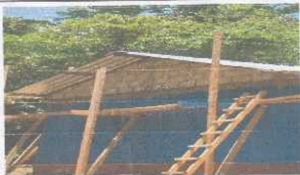
Foto 3: Ya se cerró con block la parte de arriba.
