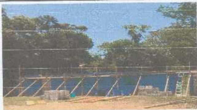
Foto 1: Esta en cambio de la estructura de Telesecundaria
